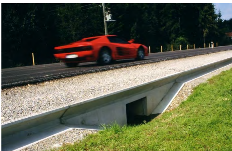
Slika 36: Pravilen način priključevanja ograje na vhod podhoda (povzeto po katalogu Zieger)
