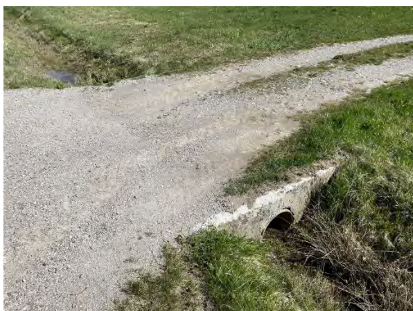
Slika 17: Prepust pod poljsko potjo
