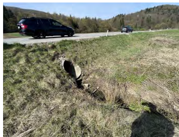
Slika 28: Prepust pod cesto z iztokom v Špeharjevo retje
