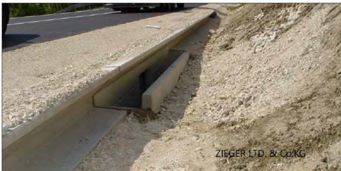
Abb.5 Tunnel Ein- und Ausgangelement mit Doppelwand zur Verhinderung des Seitenrandgrabenabflusses durch den Tunnel
